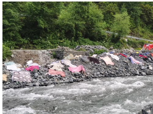
依生沟上段现状自然岸坡
